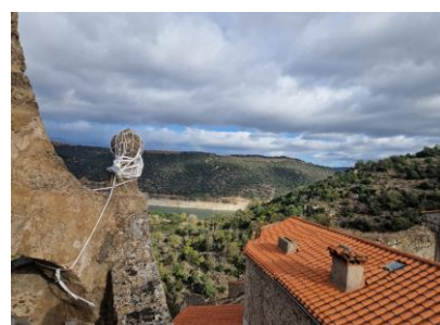
Mise en sécurité des ornements du clocher
