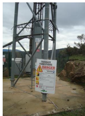
Débroussaillage des abords de l'antenne par l'ONF
