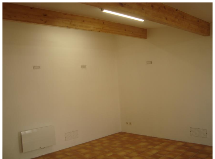
Salle d'archive avant aménagement.
