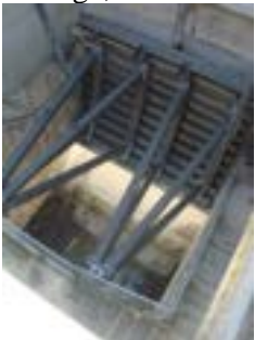
Ouverture du pertuis hydraulique. Tour et portes de captage
