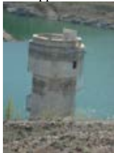
Ouverture du pertuis hydraulique. Tour et portes de captage
